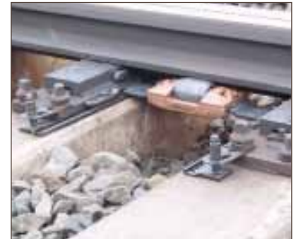
Bild 30a: Rollenböcke für Eisenbahnweichen aus Cu-Ni-Si-Legierung
