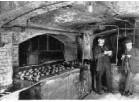
Bild 6: Die erste Cu-Raffinations-elektrolyse der Norddeutschen Affinerie in Hamburg, 1876 [5]
