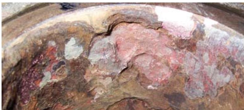
Bild 8: Schadensfall infolge von Erosion (Foto: TKMS)
