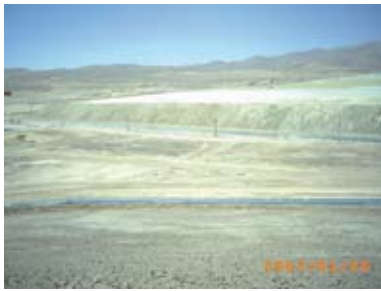
Bild 2: Biologische Haufenlaugung in Chile zur Gewinnung von Kupfer. Die Höhe der Anlage beträgt ca. 165 m. Perkoliert wird durch Schlauchsysteme, die auf der Haufenkrone verlegt sind. (Übersicht und Detail)
